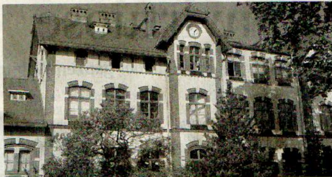
Die Rote Schule, derzeit noch als Grundschule genutzt. FOTO: ARCHIV
